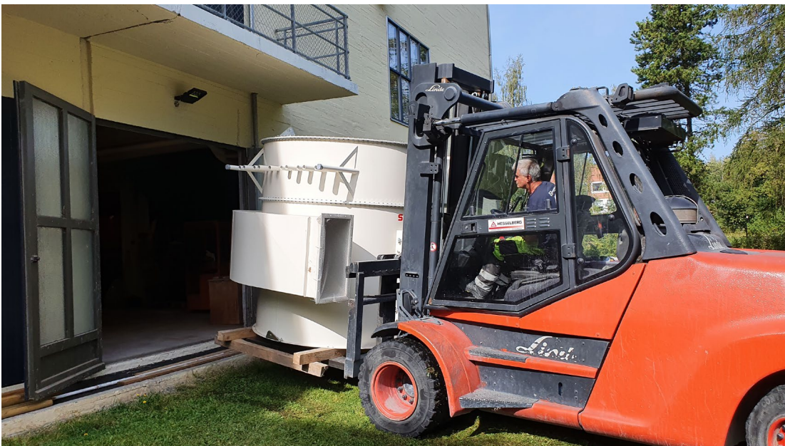
Filterenhet og motor til aspirasjonsanlegg settes på plass. Foto: Øyvind M Edvardsen.
